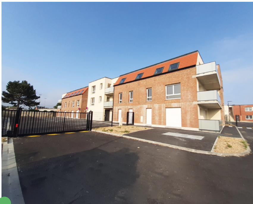
Râches 26 logements collectifs et 5 logements individuels.
