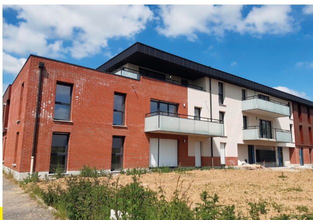
Orchies 36 logements collectifs.
